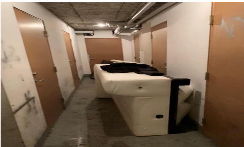
Figur 8: Dumpat brandfarligt material, källargångar
