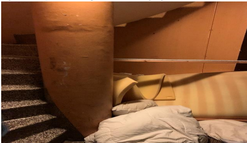
Figur 7: Dumpat brandfarligt material, källargångar
